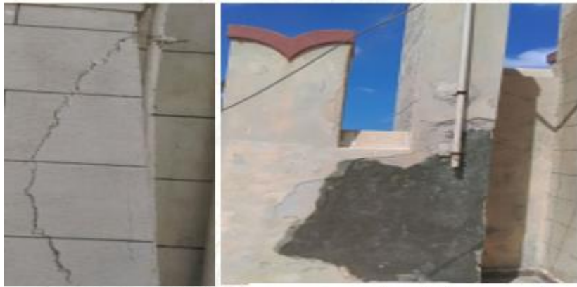
شكل 2-4 شروخ نافذة بواجهة البوابة الرئيسية المصدر: مكتب الهادي للترميم
