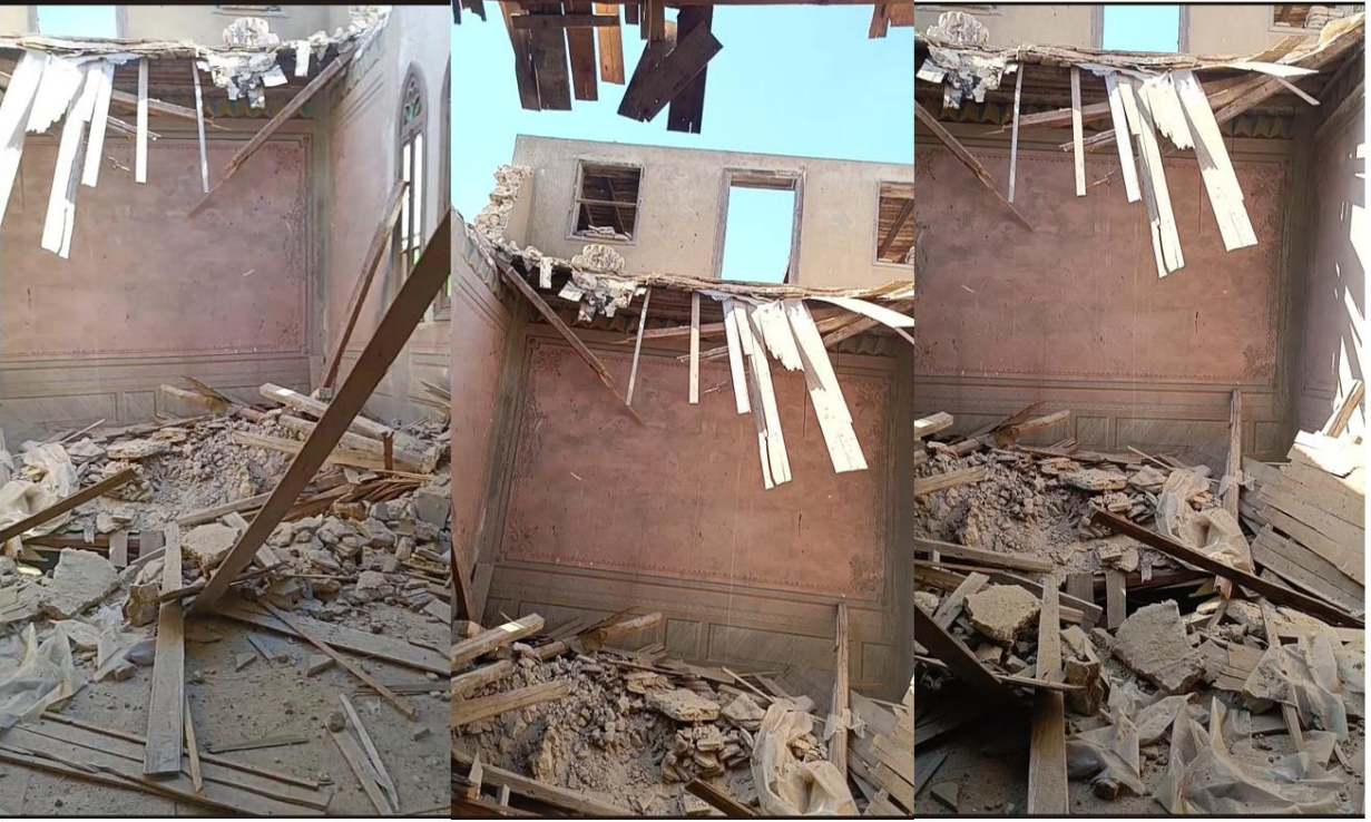
شكل 6-9 مشاكل إنشائية وتدهور بالأسقف لغرف بالقصر اثر حركات البناء والحفر المحيطة بالقصر المصدر: الباحث
